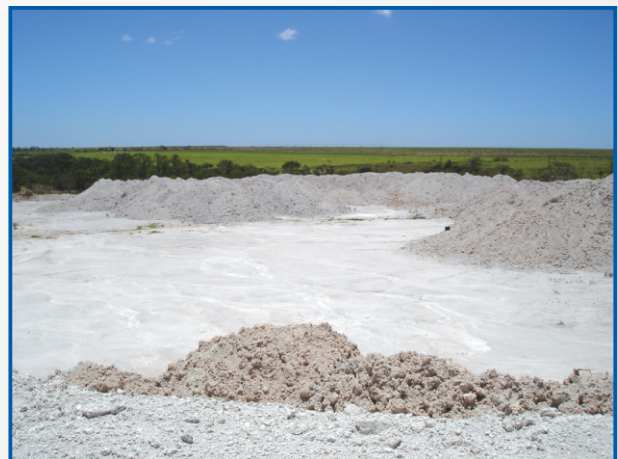
Pátio de estoque de material.
